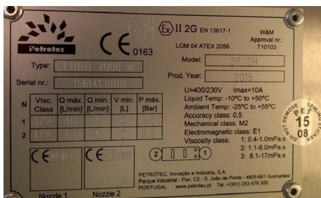
Kennzeichnungsschild der Petrotec-Säulen
