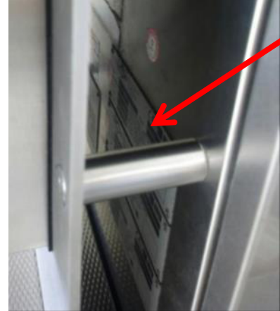
Abgedecktes Kennzeichnungsschild
