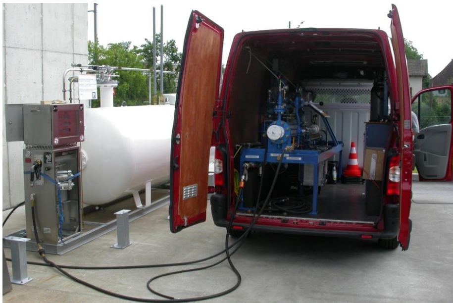
Bild 8: Mobile Prüfeinrichtung der Wartungs- und Prüfungsdienst GmbH
